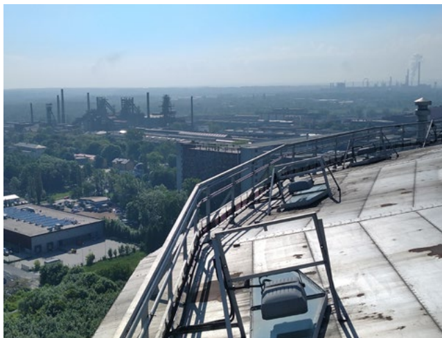
Demolice bývalé vítkovické ocelárny - foto pořízené inspektorem ČIŽP ze střechy 84 metrů vysokého plynojemu MAN před jeho zbouráním v červnu 2021
