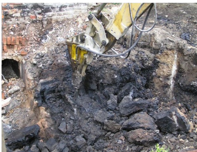
Demolice dehtových podzemních jímek
