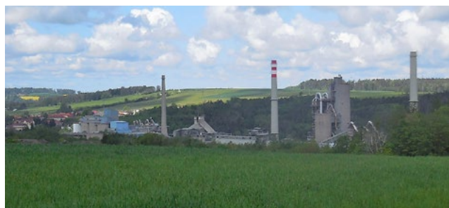
Cementárna CEMEX Prachovice
