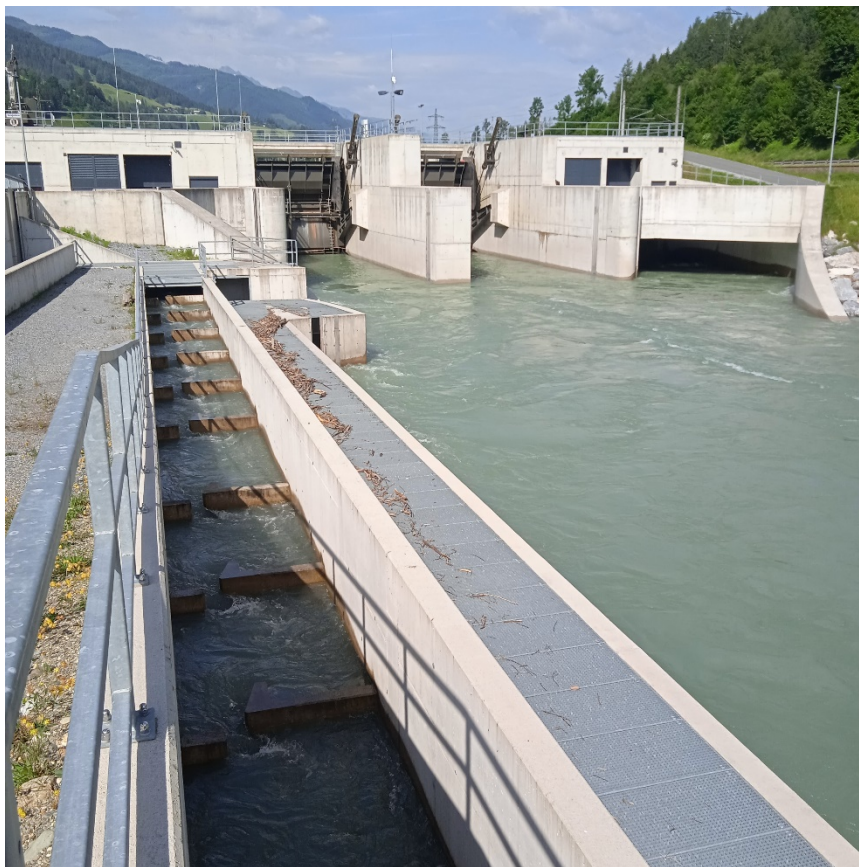
Pohled na vodní elektrárnu Gries s rybím přechodem
