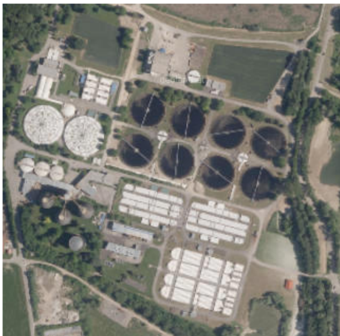
Letecký pohled na ČOV Linz
