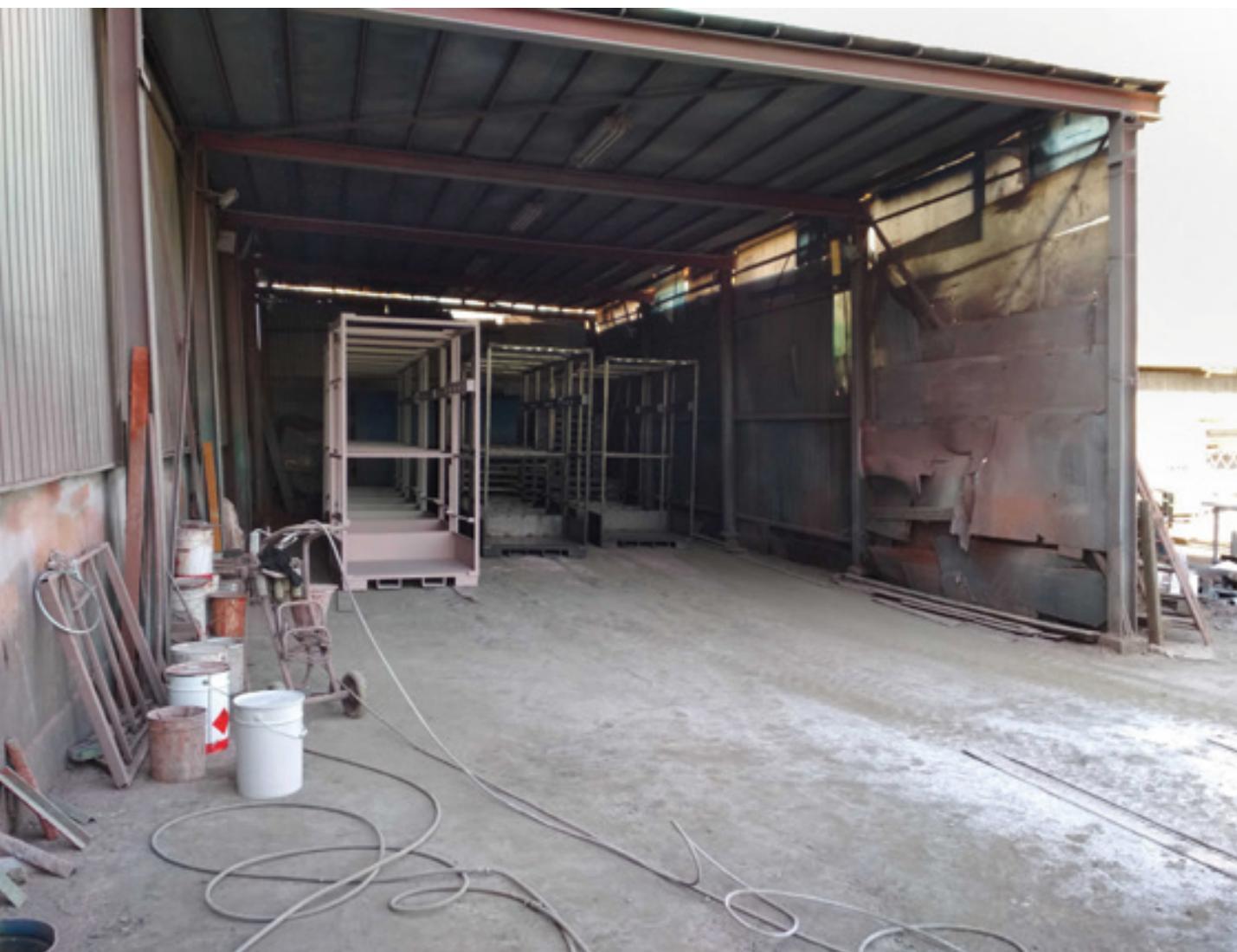
Provádění aplikace nátěrových hmot na venkovním prostranství areálu provozovny v Rokycanech
