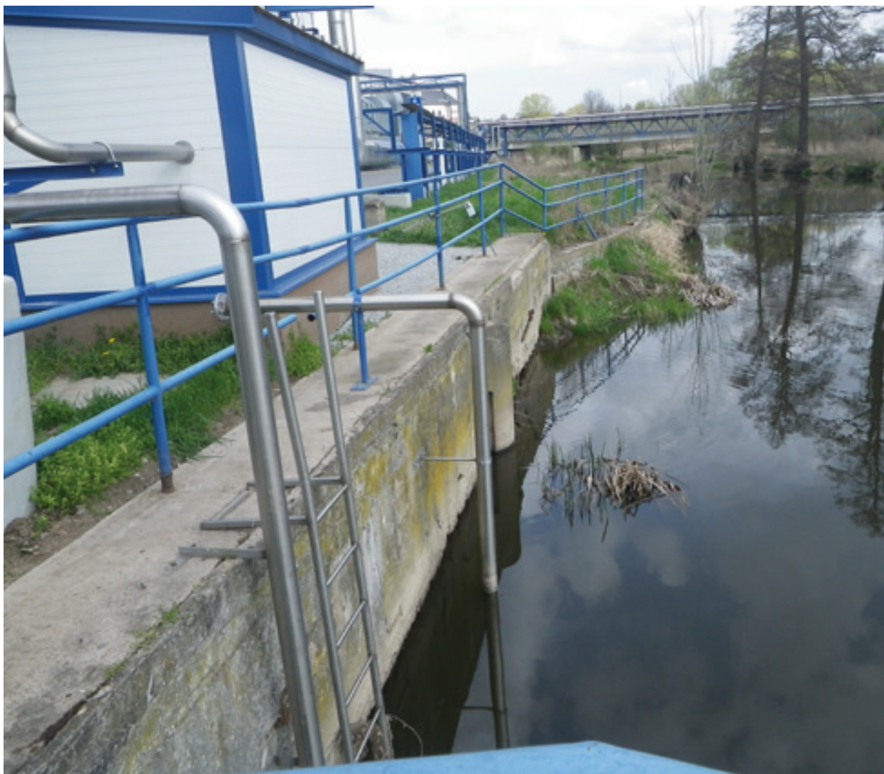
Místo vypouštění chladicí vody do vodního toku – řeka Jihlava
