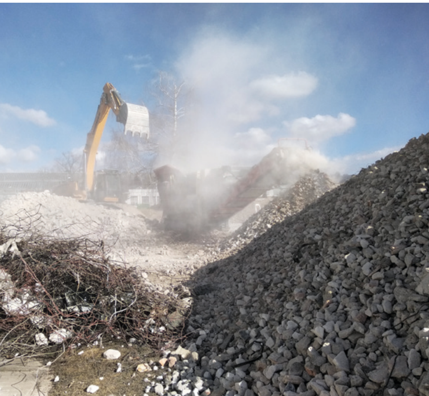
Prašnost vznikající provozem mobilní drticí jednotky v areálu brněnského výstaviště
