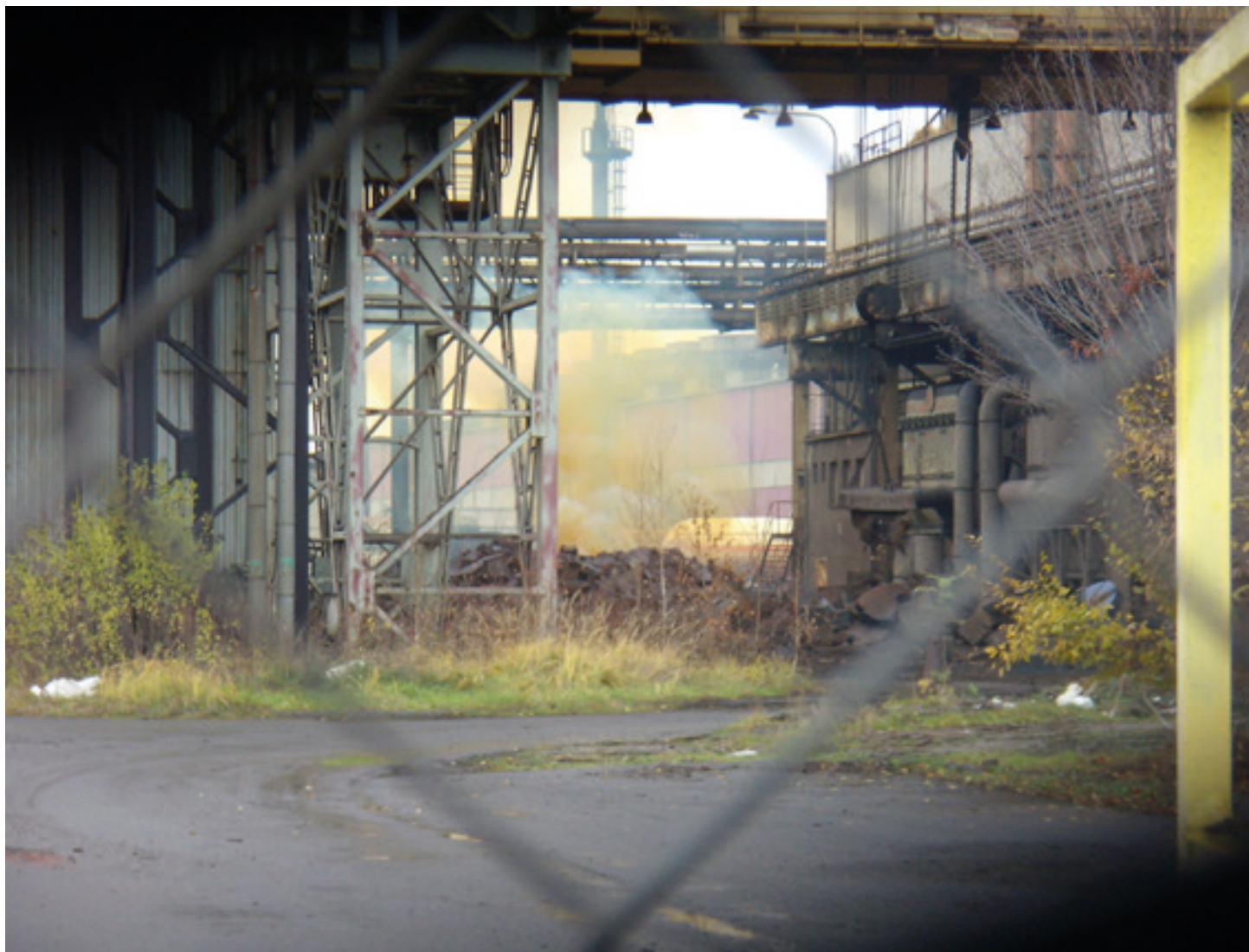
Rozpalování materiálu kyslíkovým kopím na venkovní ploše skladu kokil
