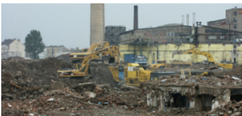
Demolice provozu galvanovny
