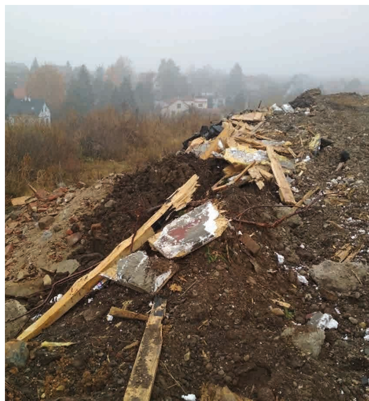
Ukládání stavebních a demoličních odpadů v místech k tomu neurčených
