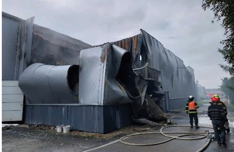
Požár v areálu CVP Galvanika s.r.o.–provoz Ždánice
