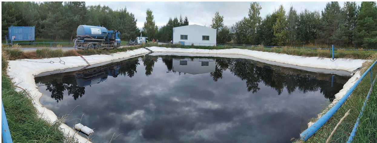
Jímka průsakových vod ze skládky odpadů
