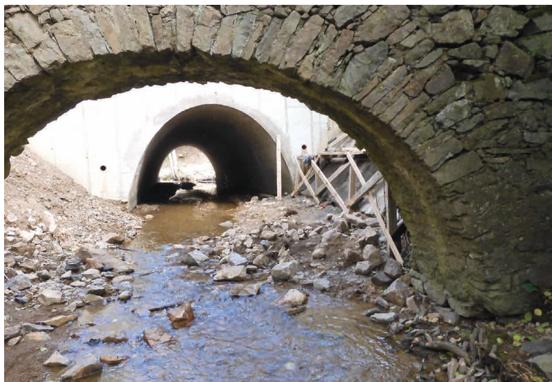
Stavební práce v korytě toku Chýlava, který je biotopem kriticky ohroženého raka kamenáče
