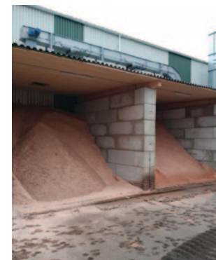
Zvýšená prašnost z nepovoleného provozu technologie zpracování dřeva
