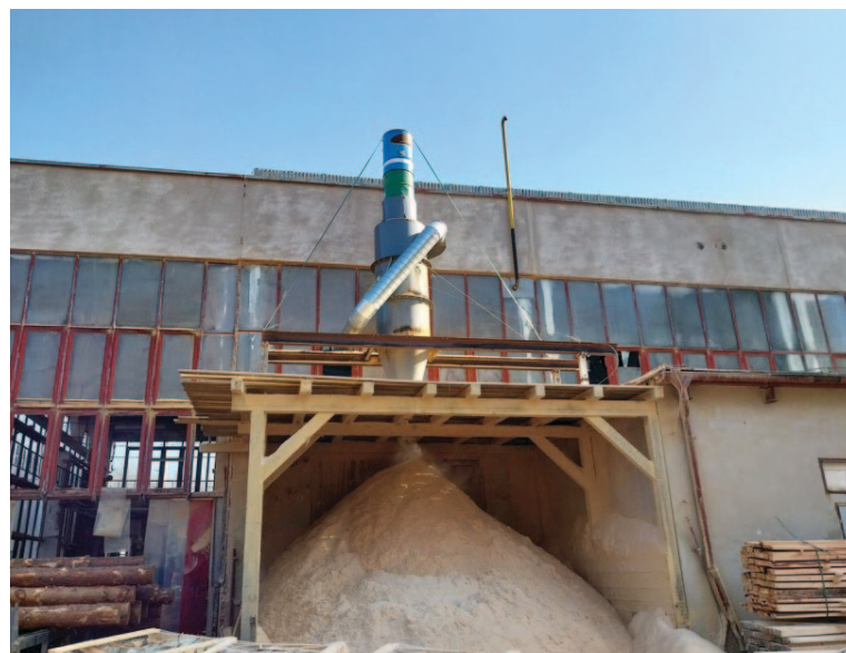
Vírový odlučovač a zachycené tuhé znečišťující látky bez zabezpečení proti úniku
