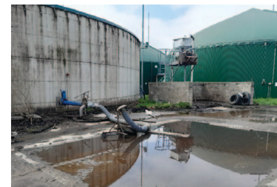
Stáček místo u koncového skladu digestátu
