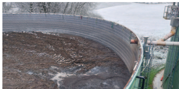
Otevřený koncový sklad digestátu, který podle provozního řádu má být plynotěsně zakryt, mj. i z důvodu omezení emisí pachových látek.
