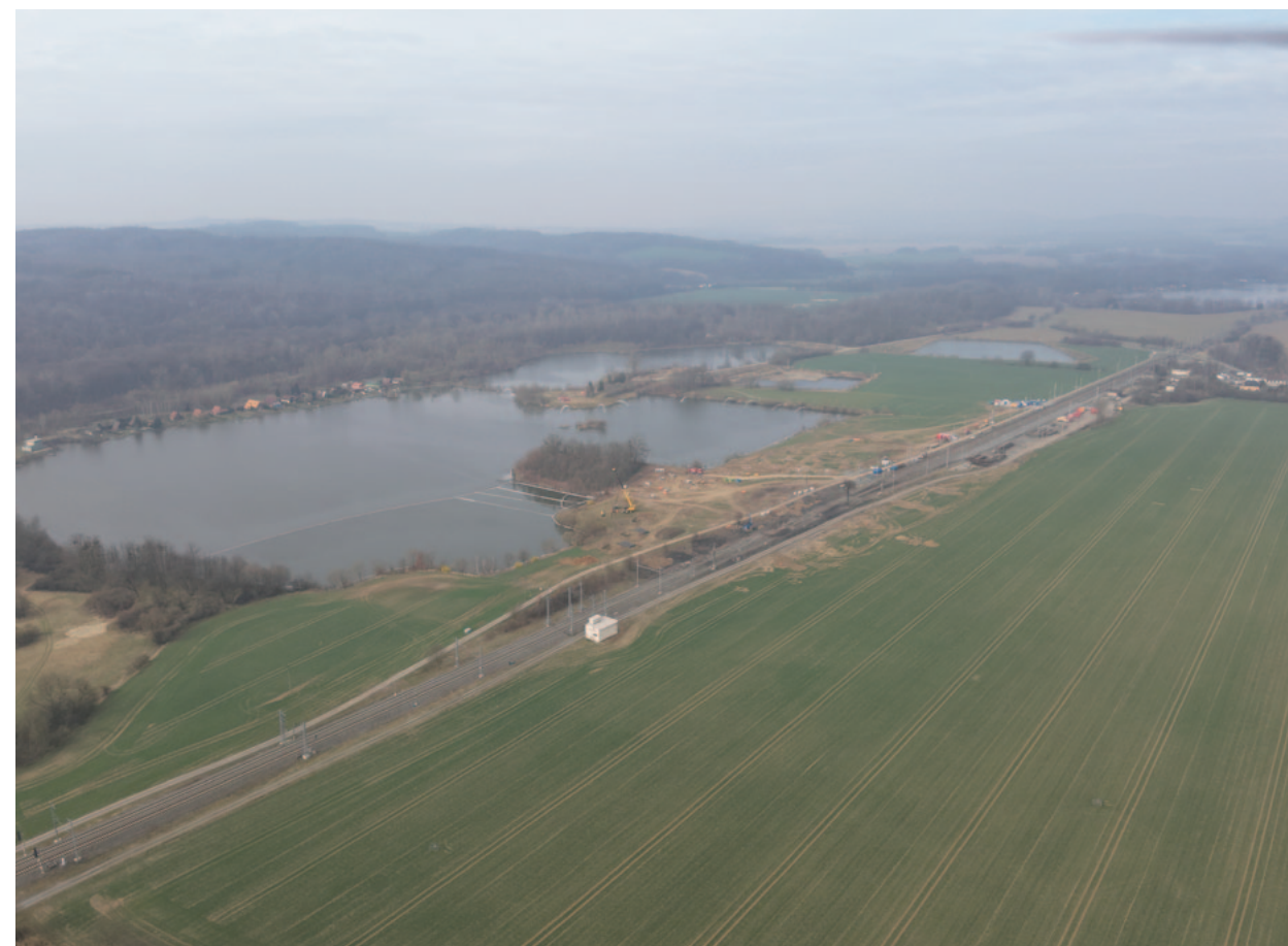
Havárie Hustopeče nad Bečvou – budování štětové stěny a provzdušňování povrchové vody
