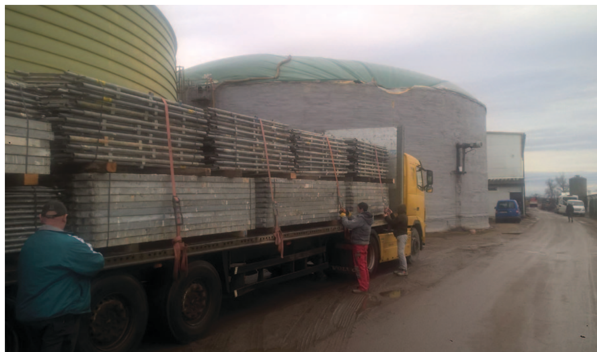
BPS Velký Karlov VK, s. r. o., provozovna Velký Karlov, poškození fermentoru F0
