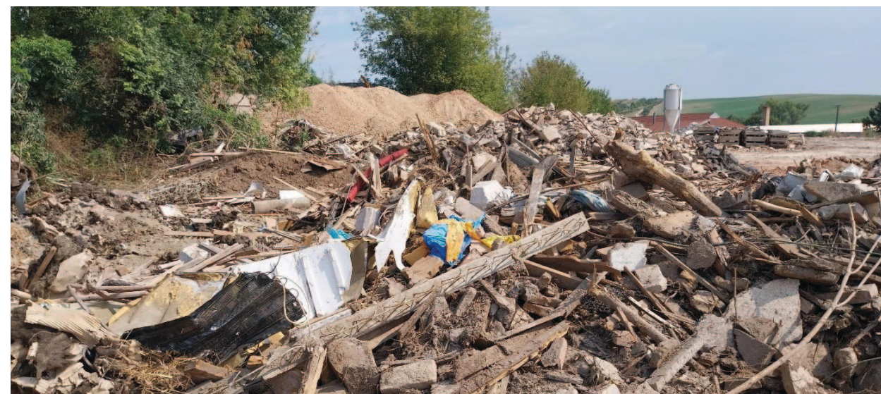
Závadné nakládání s demoličním odpadem a s azbestovým odpadem
