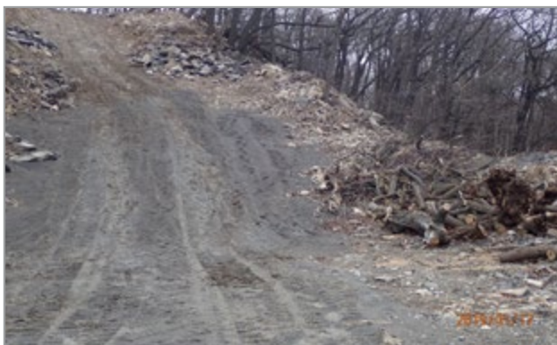
Firma KERAMOST a.s. vybudovala cestu do lomu na pozemcích určených pro plnění funkcí lesa.
