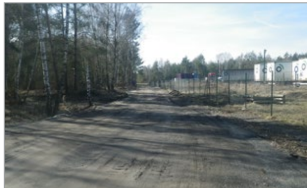
Společnost Valcha Property Development a.s. vybudovala zpevněnou cestu v místě, kde měla být vegetace a biotop pro ohrožené obojživelníky.
