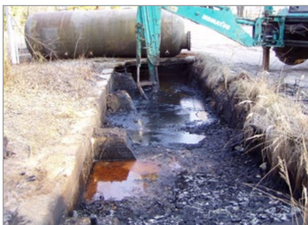
Vymístování dehtových kalů při sanaci staré ekologické zátěže.
