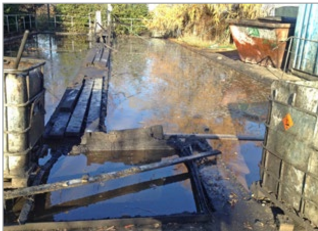
Plná jímka přijatého odpadu.
