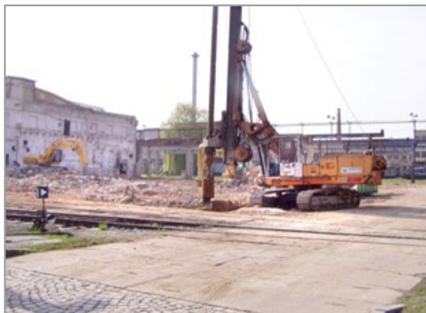
Sanační práce související se statickým zajištěním výkopu.
