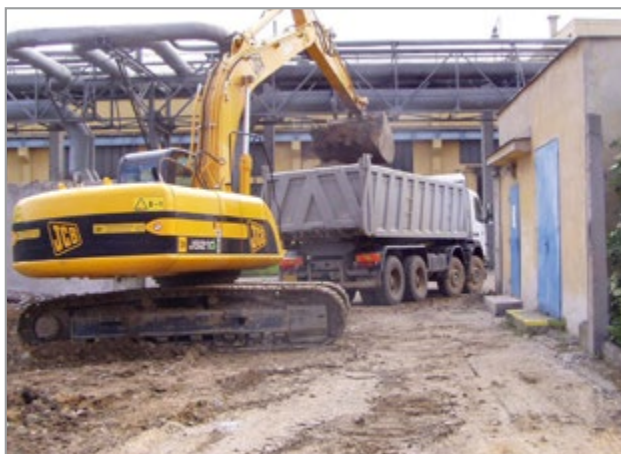
Sanační práce související s odstraněním kontaminovaných zemín.
