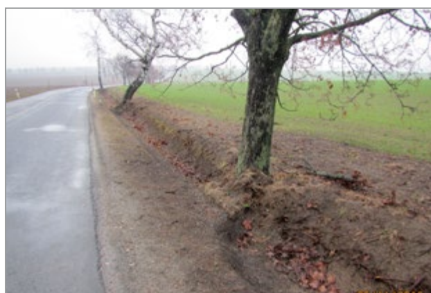
Poškození kořenových systémů doprovodné silniční zeleně při strojním hloubení příkopů pozemních komunikací v k. ú. Repechy, Bousín, Drahaný, Otínoves a Niva.
