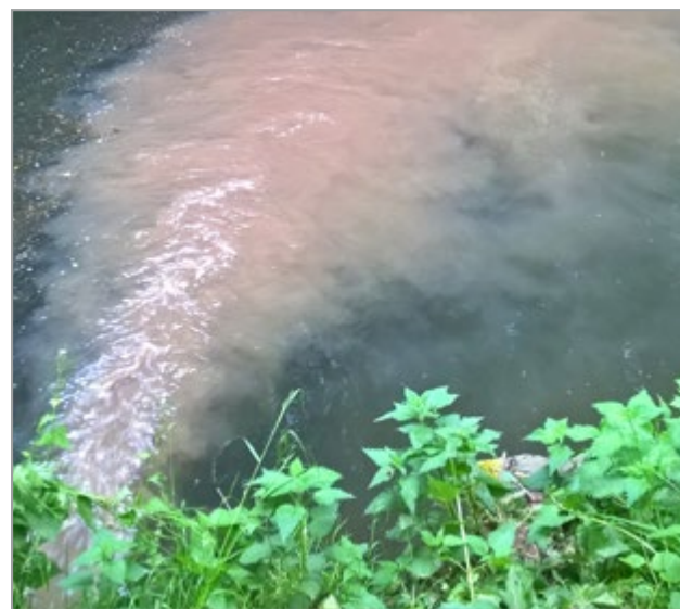
Výúst z ČOV - nedostatečně čištěné odpadní vody.
