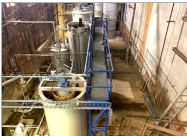
SVAZIKO VYŠKOV, s.r.o. – rekonstrukce neutralizační stanice.
