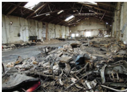
Vnitřní prostor budovy.
