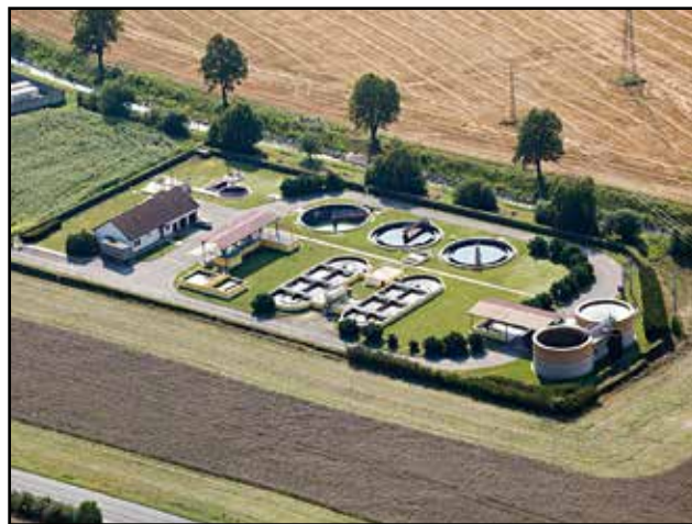
Pohled na ČOV Bučovice
