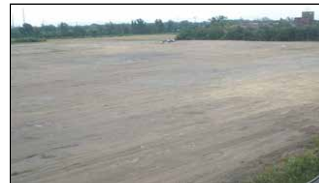
Agglomerace – Dolní oblast VÍTKOVICE, a.s., – sanační práce v průběhu a po ukončení zásahu
