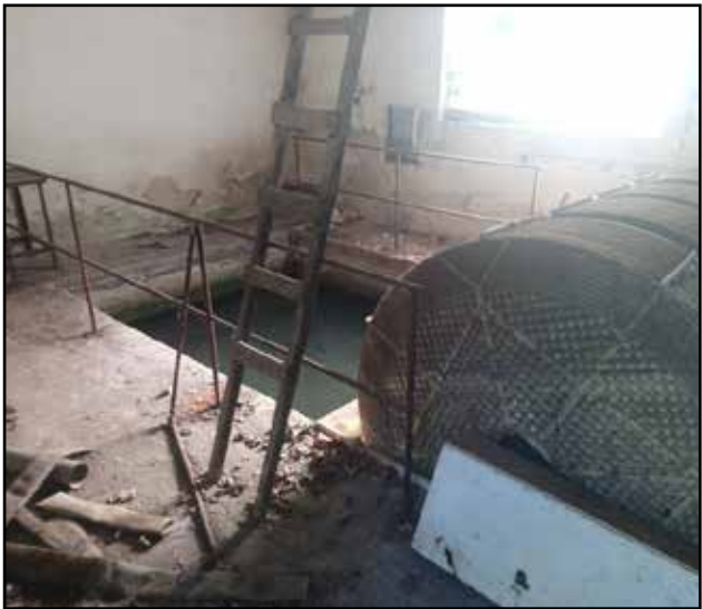
ČOV rekreačního areálu – nefunkční biodisková ČOV
