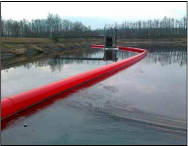
Havárie – Sokolovská uhelná, právní nástupce, a.s.
