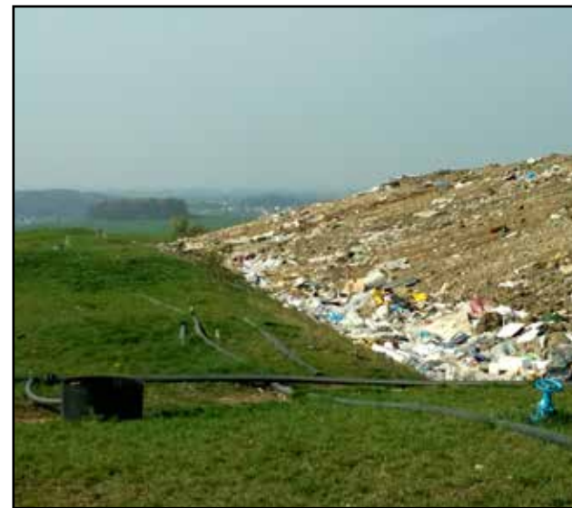
Překročení kapacity skládky – skládkování nad stanovenou maximální výškovou kótu
