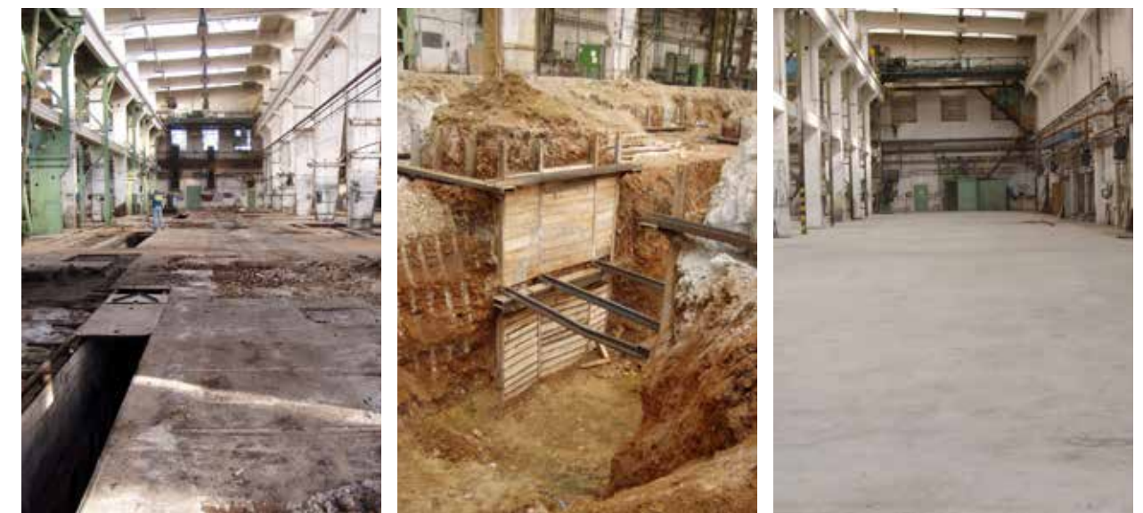
Takto probíhaly sanační práce související s odstraněním kontaminace v areálu závodu ŠKODA INVESTMENT a.s. (před sanací, během sanace a po ní).
