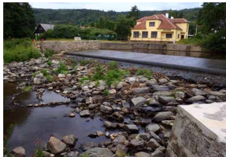
Pohled na jez na řece Svratce.
