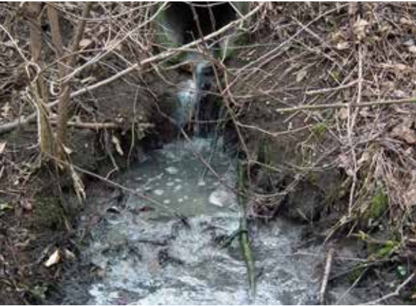
Pohled na výúst kanalizace odvádějící srážkové vody z obce.
