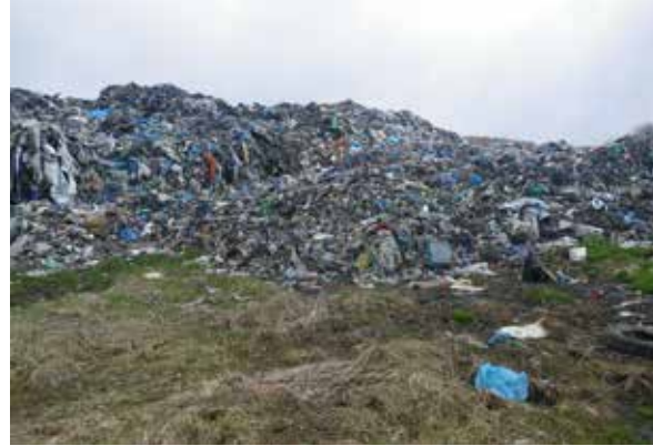
Nedodržení aktivní plochy skládky odpadů – skládka odpadů Slavičín – těleso (OI Brno)
