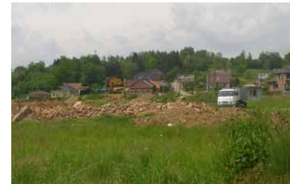
AMT SERVIS s.r.o., Vílanec u Jihlavy - navážka stavebních odpadů a výkopových zemin bez souhlasu provozování zařízení k využívání, odstraňování, sběru nebo výkupu odpadů (OI Havlíčkův Brod)
