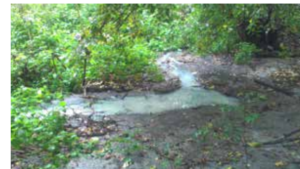
Podnět vypouštění (únik) odpadních vod na lesní pozemek v nivě řeky Moravy, k. ú. Dub nad Moravou
