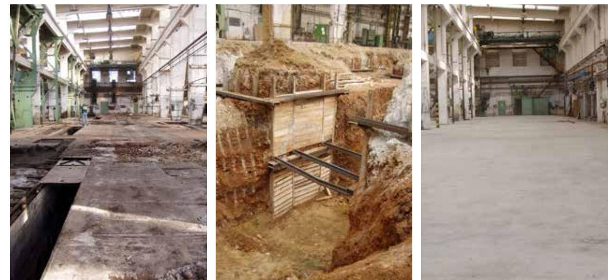
Takto probíhaly sanační práce související s odstraněním kontaminace v areálu závodu ŠKODA INVESTMENT a.s. (před sanací, během sanace a po ní).
