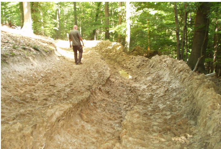
poškození PUFL při přibližování dřeva
