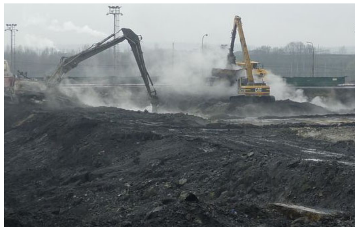
vsázka po požáru
