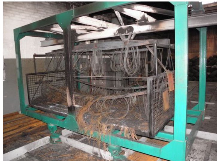
vsázka po požáru
