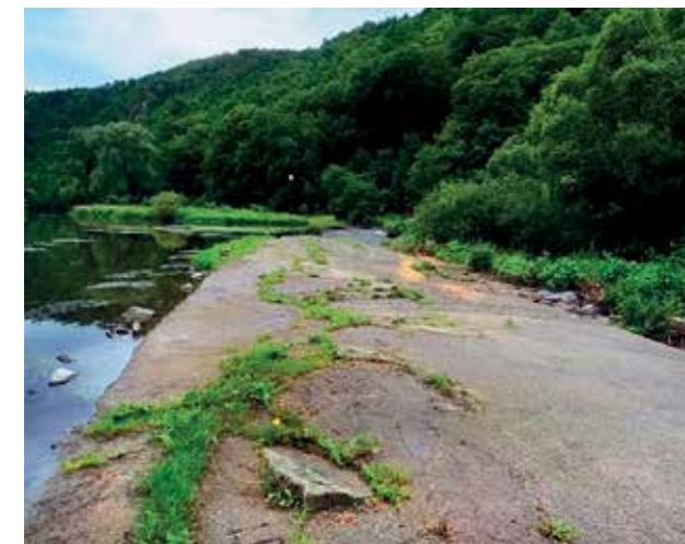
Pohled na jez na řece Svratce u MVE Veverská Bítýška I. (OI Brno)
