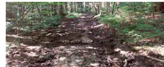
Stav těžby svážnice při následné kontrole po provedené asanaci
