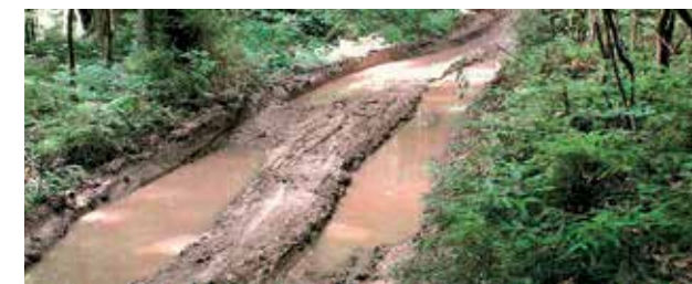
Kontrola na základě podnětu – povrch svážnice v k. ú. Hůzová, okr. Olomouc, narušené a zamokřené po provedeném přibližování kůrovcového dříví
