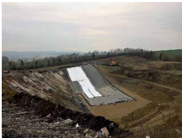
Výstavba nového skládkového pole na skládce odpadů Hradčany provozované společností SUEZ Využití zdrojů a.s. (OI Olomouc)
