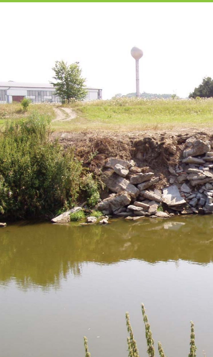
Zásah do VKP – navázka stavební suti – břeh řeky Moravy, k.ú. Věrovaný
