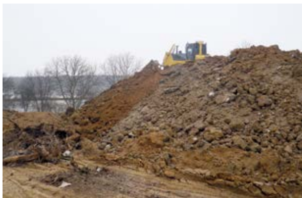
Nepovolené terénní úpravy
